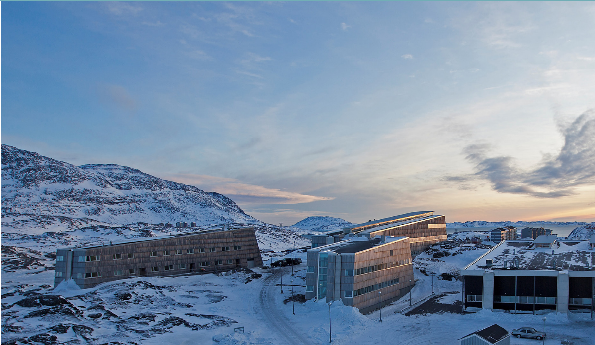
I 2011 blev Pinngortitaleriffiks nye tilbygning indviet og instituttet råder nu over ca. 3.600 kvadratmeter i Nuuk. Tilbygningen er ligesom instituttets øvrige bygninger doneret af Aage V. Jensens Fonde. Sammen med feltstationer, skibe og mindre både giver dette optimale betingelser for en bred og aktiv forsknings- og monitoringsindsats i det arktiske område.
